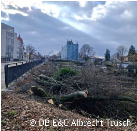
Abb. 2 bis 02/2024 erfolgte Fäll- und Rodungsarbeiten
