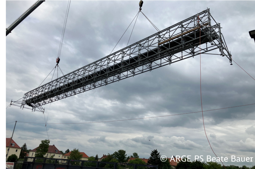
Abb. 2 Einbau Kabelhilfsbrücke neben SÜ Koburger Straße
