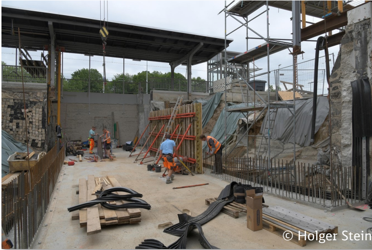
Abb. 1 EÜ km 38,575 Personenunterführung – Schalung Wände
