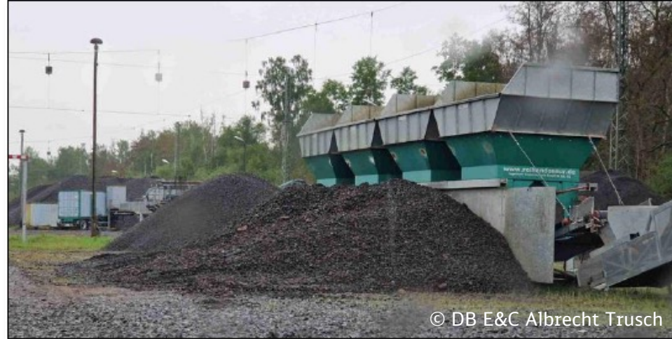
Abb. 2 Schotteraufbereitung auf Baueinrichtungsfläche
