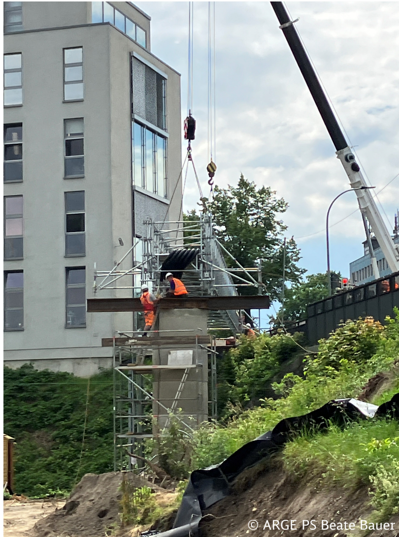
Abb. 3 Aufbau Kabelhilfsbrücke
