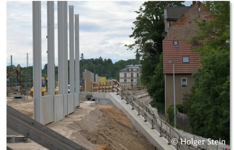
Abb. 5 Aufbau LSW 3 und Stützwand 7 – Kopfbalken
