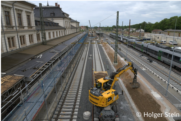
Abb. 3 Bahnsteig 4 und Einkürzen Dach Hausbahnsteig
