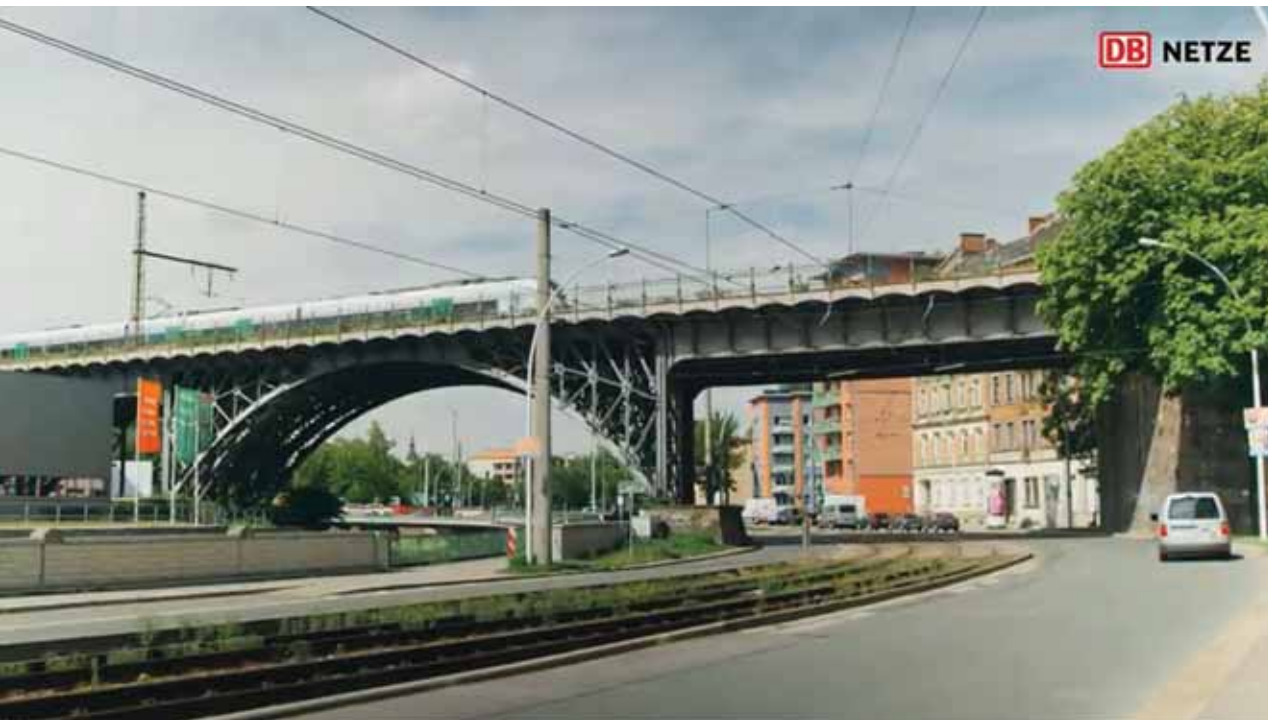
Chemnitzer Viadukt (DB AG)
